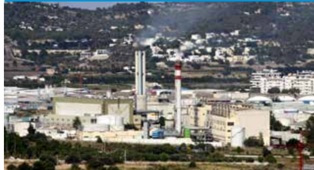
Central térmica GESA
