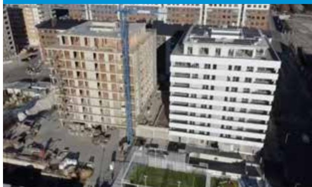
Residencial Cúbicos Viviendas
