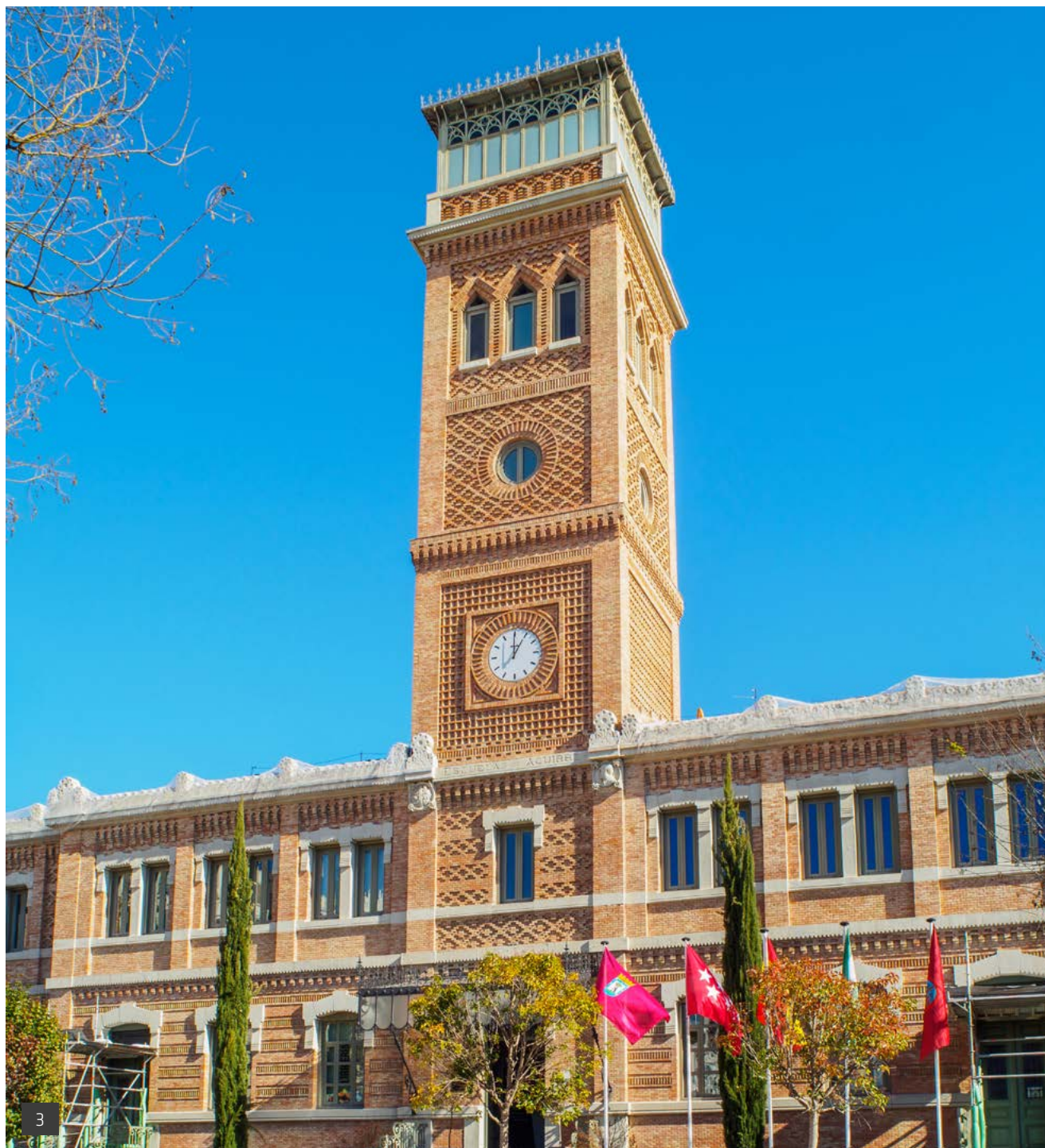
3. Casa Árabe (Edificio público): Madrid (España), KAYNET.
